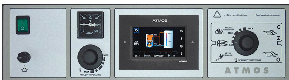
Katla vadības panelis ar vienādmalu regulēšanu ATMOS ACD 03
